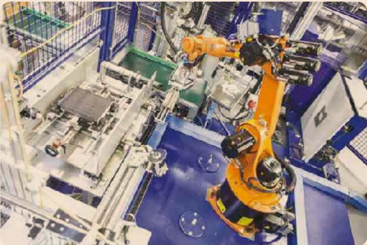
Un dettaglio della linea di produzione automatizzata del plant di Air Top Italia
